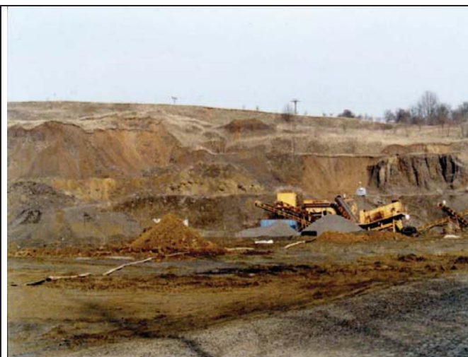
Foto č. 2: Lom Žandov – střední část – zahloubení
