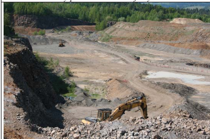
Foto č. 3: Celkový pohled do lomové jámy
