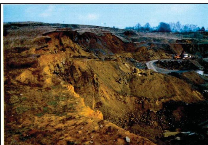
Foto č. 5: Pohled na lomový areál směrem sv.
