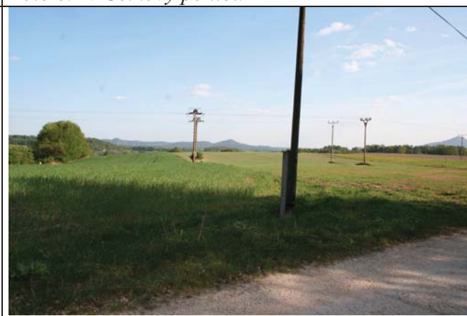
Foto č. 4: Celkový pohled
