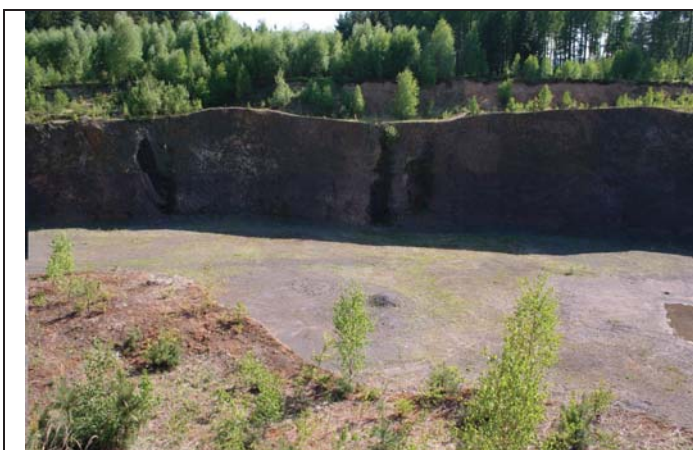
Foto č. 1: Pohled na etáže lomu
