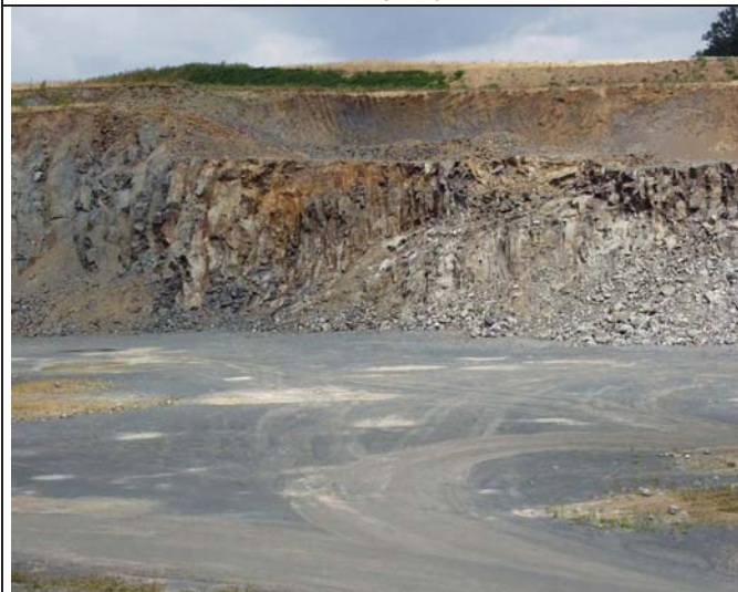
Foto č. 3: Pohled na etáže lomu
