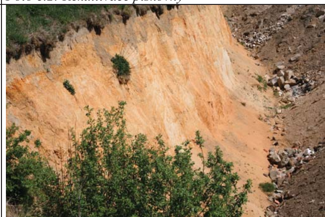
Foto č. 4: Detail stěny pískovny
