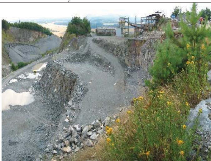
Foto č. 4: Detail lomové stěny s technologickým celkem v pozadí
