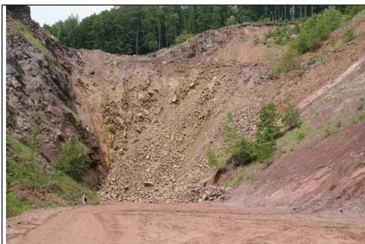
Foto č. 1: Celkový pohled
