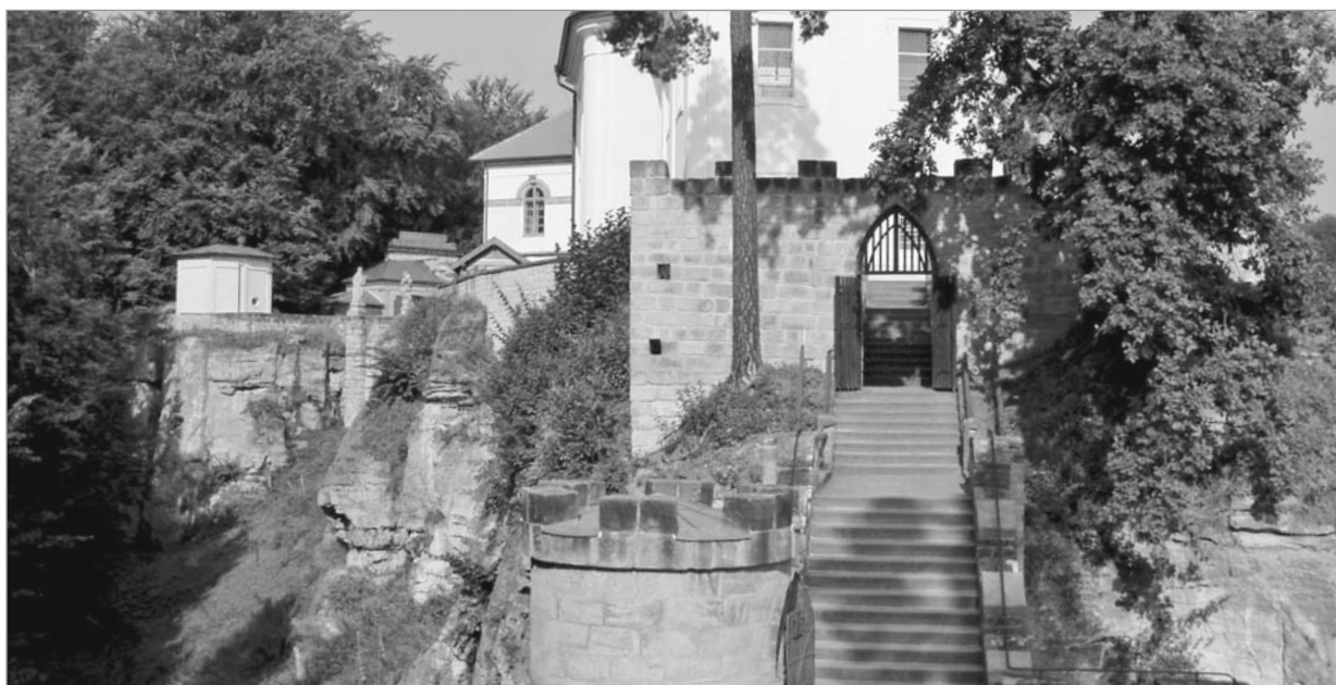
Valdštejn – pohled od hladomorny
