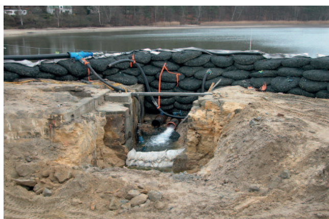
Máchovo jezero - vlastní rekonstruované výpustní zařízení
