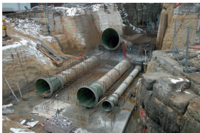
Máchovo jezero - vlastní rekonstruované výpustní zařízení
