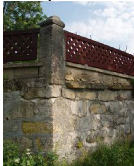
Žibřidice (okr. Liberec). Novodobá kombinace kamenné podezdívky, pískovcových sloupků a dřevěných dílců.
