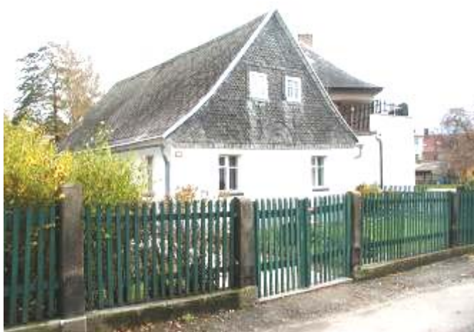
Hrádek nad Nisou, dům čp. 220. Dřevěný plaňkový plot s betonovými sloupky a betonovou podezdívkou z prostředí periferie malého města.
